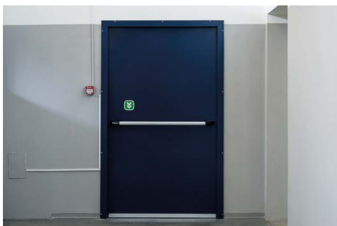
Modello tagliafuoco corredato di maniglione push interno.
